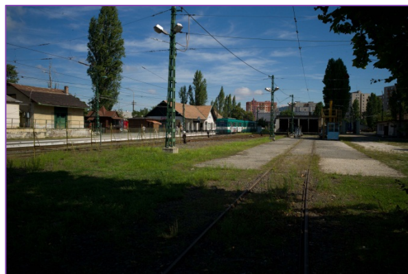
15. kép: A HÉV-végállomás a kihúzóvágányok felől
