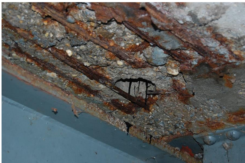
5. ábra Pályalemez állapota pályamegcszakítás mellett (PROVIX HÍD Kft. felvétele)
