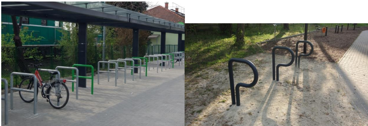
3.16. ábra Mai elvárásoknak megfelelő kerékpártárolók a kerületben
