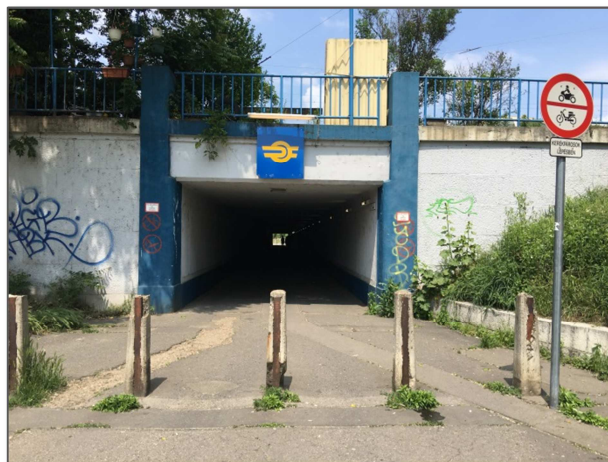
3. fénykép: Vasúti aluljáró a Kolozsvári utcánál
