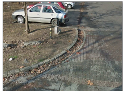
9. fénykép: kedvezőtlen kialakítás (kerékcsapda)
