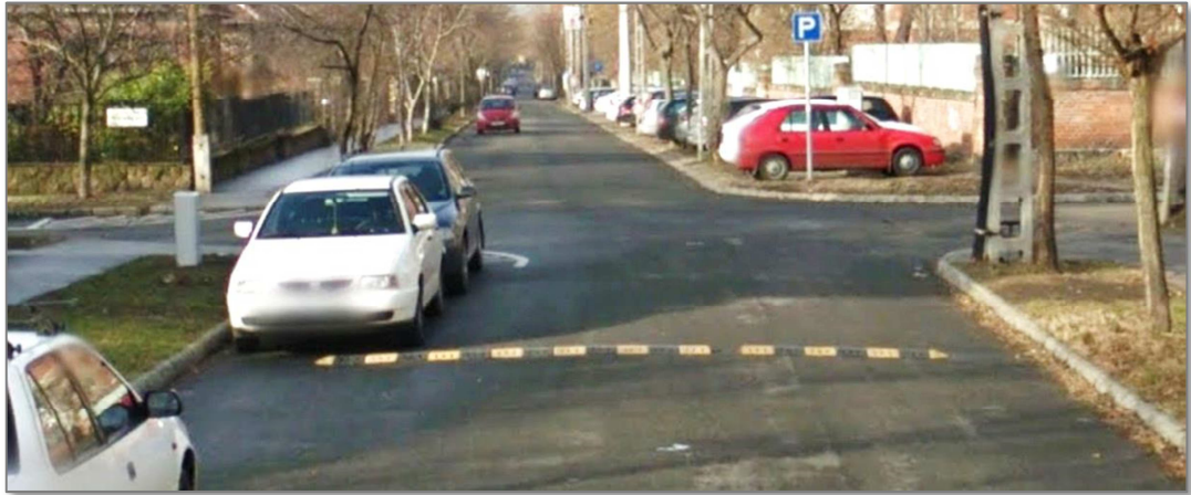
7. fénykép: Előregyártott, dűbelezett, sebességcsillapító borda
