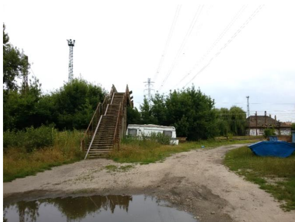
Rákosrendező vasútállomás külön szintű keresztezése
