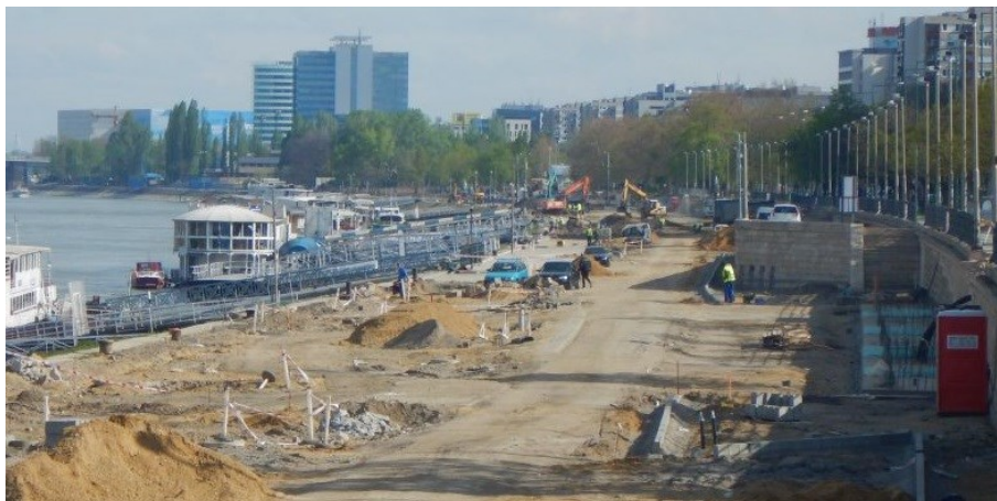
21. ábra: Az átépítés alatt álló rakpart (Margit-híd – Dráva utca)
