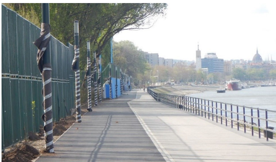
22. ábra: A Dagály uszoda irányába vezető elválasztott gyalog- és kerékpárút építése (Dráva utca – Rákospatak)
