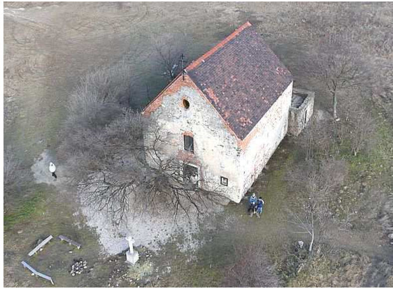
3. fotó: Az újjáépített gercsei templom madártávlatból
