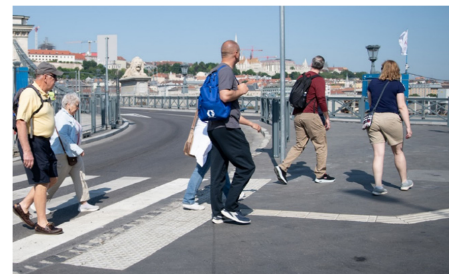
18. ábra: Veszélyre figyelmeztető taktilis burkolat és taktilis vezetősáv burkolat gyalogátkelőhelynél, forrás BKK
