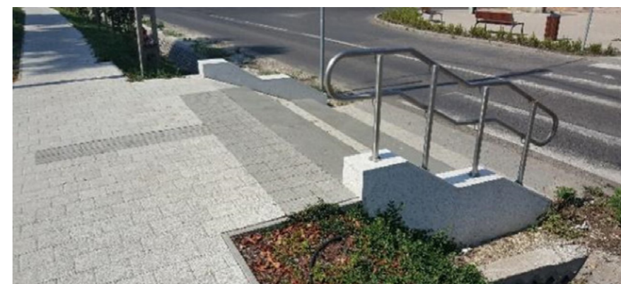
35. ábra - helyes a veszélyre figyelmeztető taktilis jelzés, a rávezető sáv kialakítása és az oldalsó-alsó szegélyek lépcső tetején, hiba, hogy nem megfelelően kontrasztos, az egyik oldalon hiányzik a korlát, forrás: ETIKK
