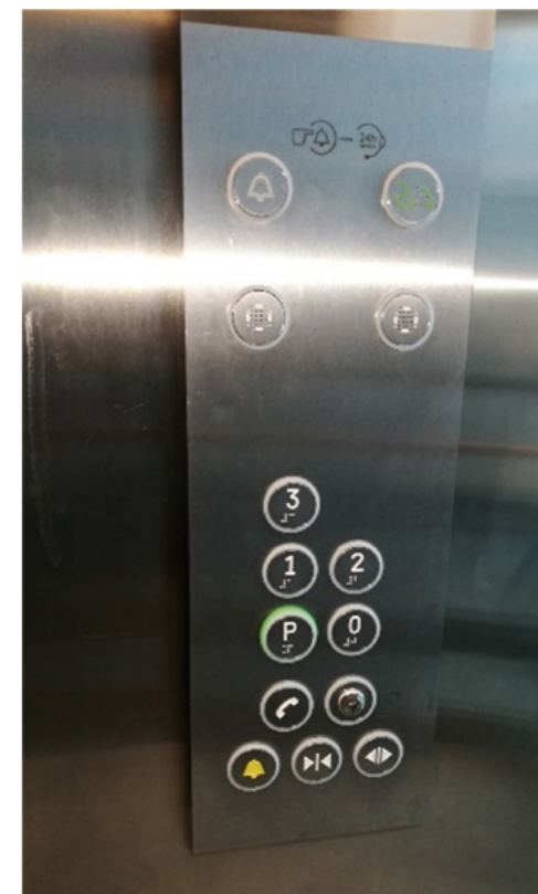
37. ábra - akadálymentes liftpanel, domború jelzésekkel és Braille jelöléssel, forrás: ETIKK
