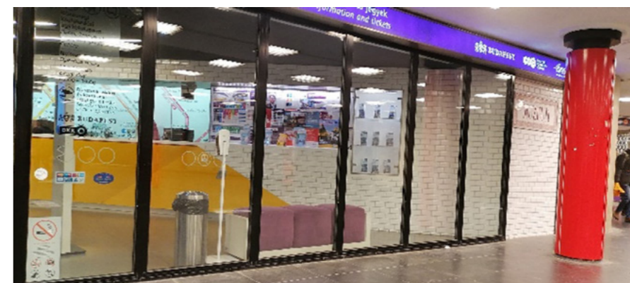
42. ábra - ügyfélközpont kialakítása az aluljáróban, üvegfelületek kontrasztos jelölése hiányzik, forrás BKK
