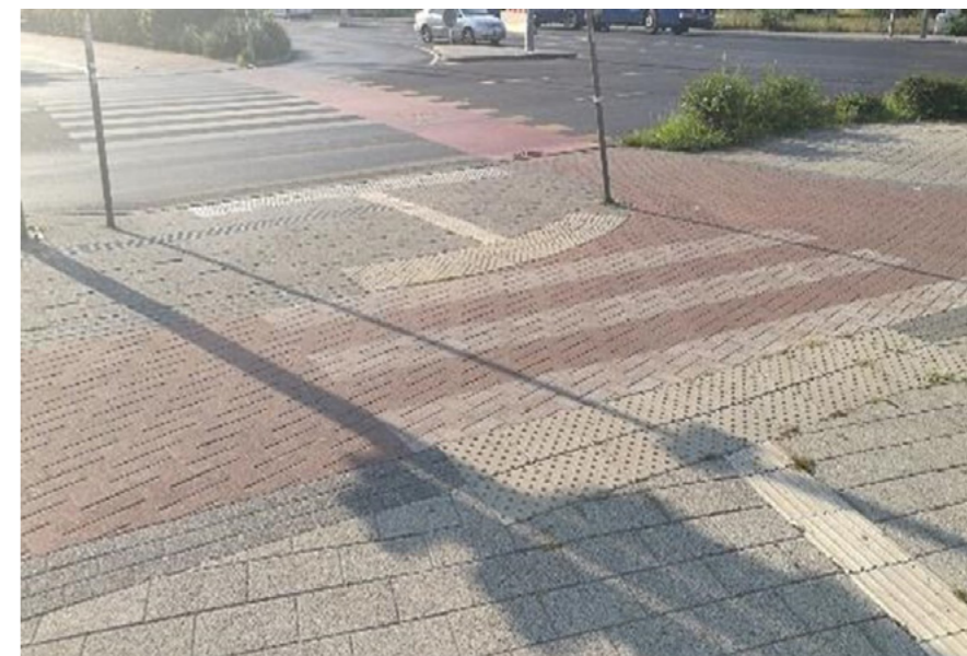
29. ábra - kerékpárutat keresztező átkelő taktilis jelzésekkel, nem megfelelő kontraszttal (Kőbánya-Kispest), forrás: ETIKK
