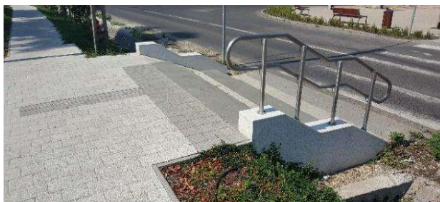
35. ábra - helyes a veszélyre figyelmeztető taktilis jelzés, a rávezető sáv kialakítása és az oldalsó-alsó szegélyek lépcső tetején, hiba, hogy nem megfelelően kontrasztos, az egyik oldalon hiányzik a korlát, forrás: ETIKK
