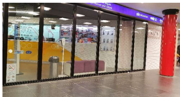
42. ábra - ügyfélközpont kialakítása az aluljáróban, üvegfelületek kontrasztos jelölése hiányzik, forrás BKK
