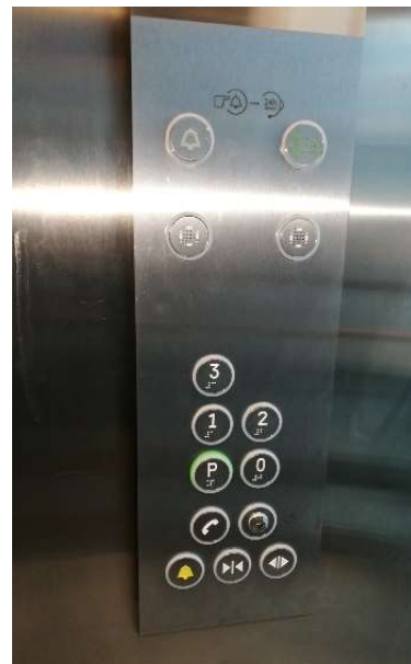
37. ábra - akadálymentes liftpanel, domború jelzésekkel és Braille ielöléssel, forrás: ETIKK
