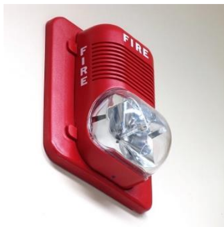
6. ábra - tűzjelző rendszer, amely fény és hangjelzést ad, forrás
