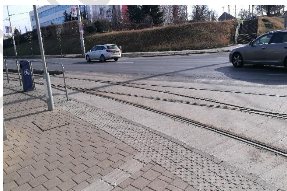
27. ábra - akadálymentes szegély kialakítása gyalogos átkelőhelyen, 1-es villamos átkelője, nem megfelelő kontraszttal , forrás: ETIKK
