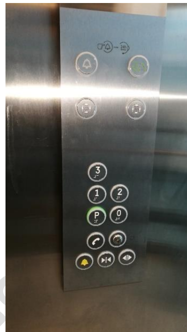
37. ábra - akadálymentes liftpanel, domború jelzésekkel és Braille jelöléssel, forrás: ETIKK
