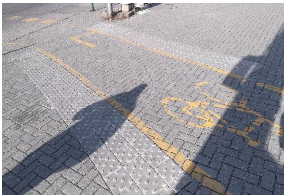
28. ábra kerékpárút és gyalogos forgalom kereszteződése, nem megfelelő kontraszttal (Lurdy ház), forrás: ETIKK
