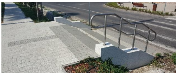
35. ábra - helyes a veszélyre figyelmeztető taktilis jelzés és a rávezető sáv kialakítása és az oldalsó-alsó szegélyek, hiba, hogy az egyik oldalon hiányzik a korlát, forrás: ETIKK
